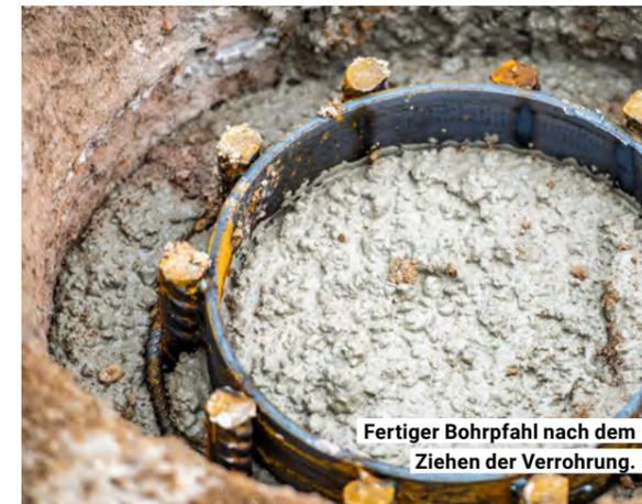
Fertiger Bohrpfehl nach dem Ziehen der Verrohrung.
